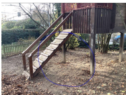
Fallschutzboden fehlt
