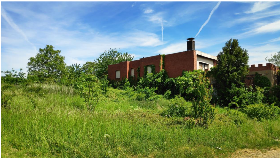
Abbildung 2: Blick auf das Weincastell mit vorgelagertem Gehölzaufwuchs (Blickrichtung Ost-Süd-osten)
