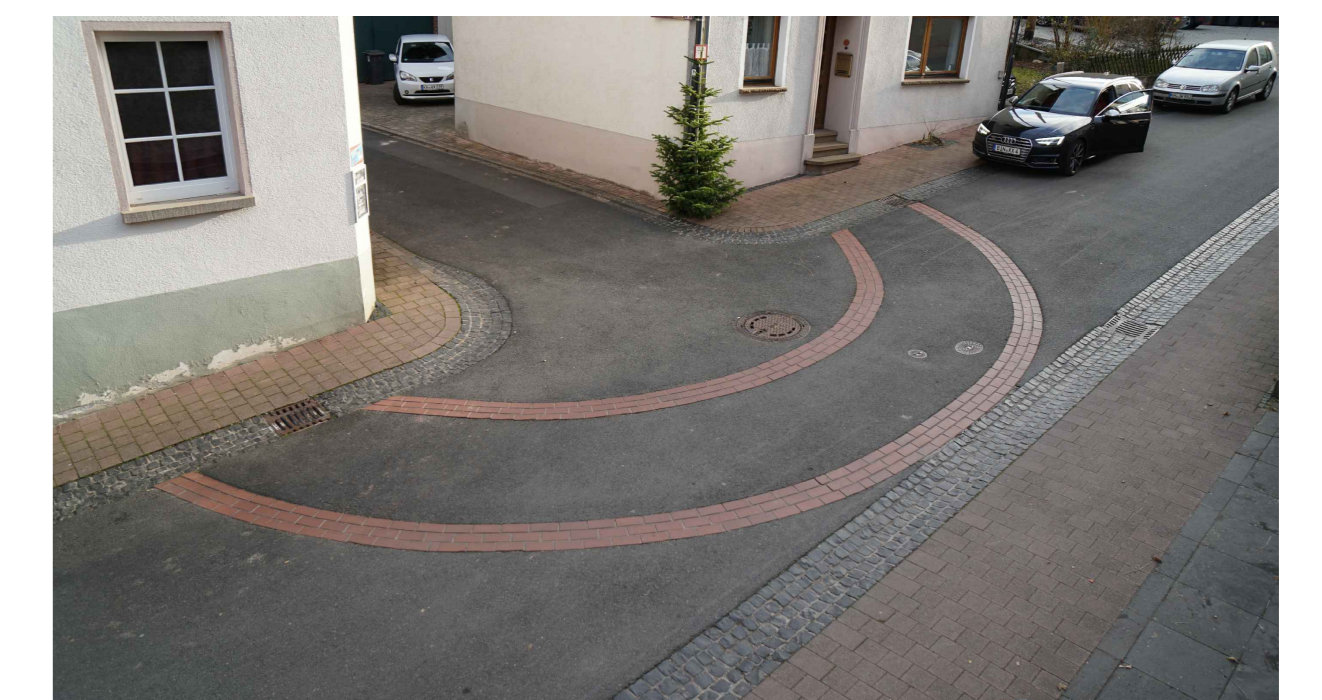
Abb. 4: Beispiel Einlegearbeiten in Einmündungsbereichen
