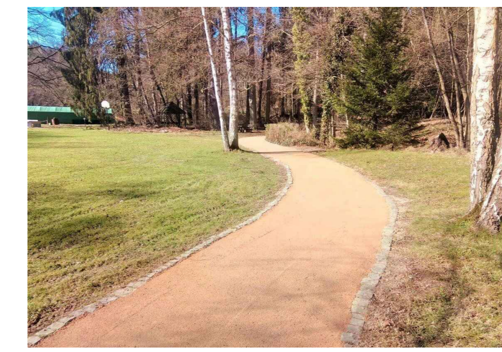
Abb. 1: Fußweg, wassergebunden, Einfassung Basalt
