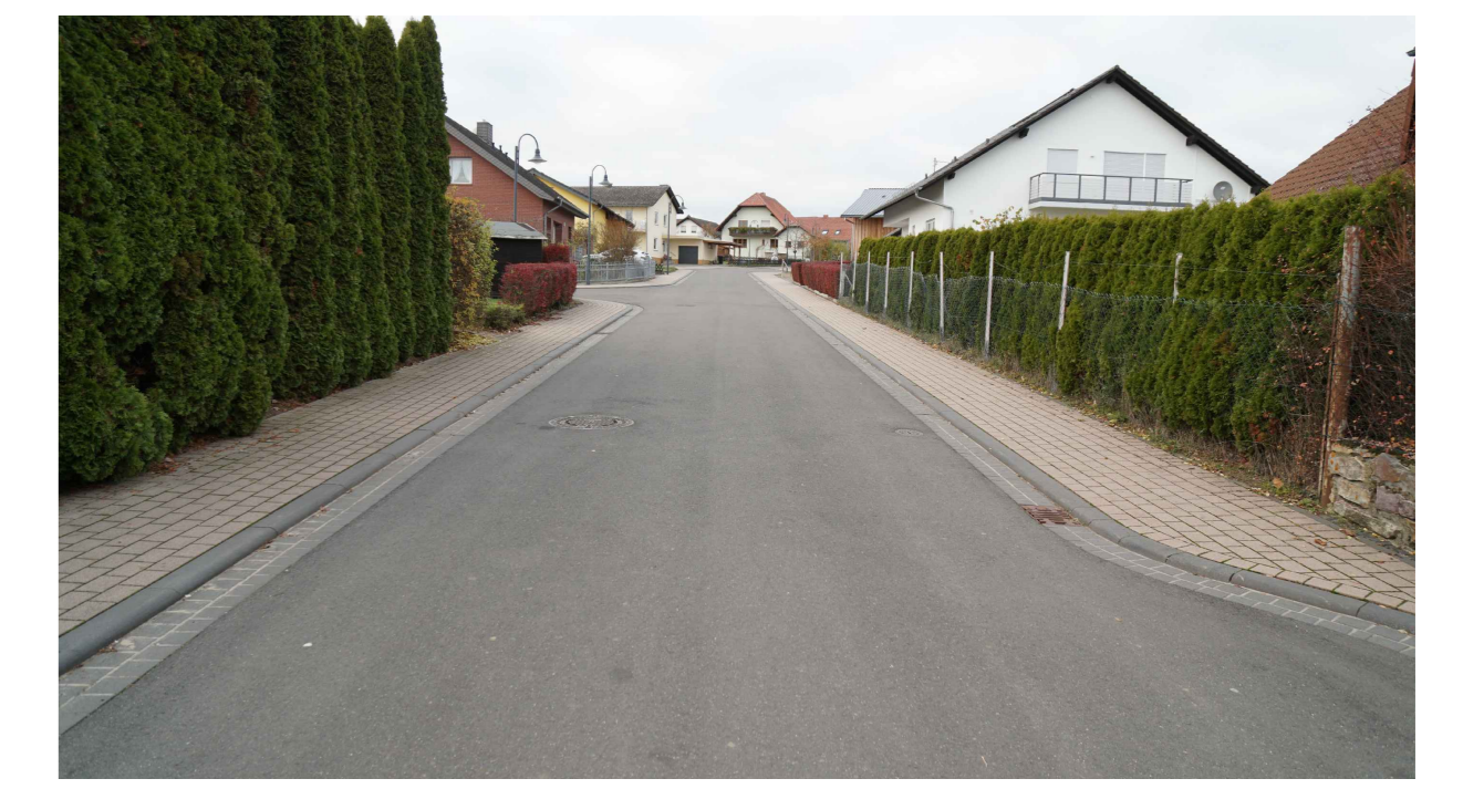
Abb. 2: Beispiel Hauptachse, Asphaltbauweise, Gehwege mit Rundbord
