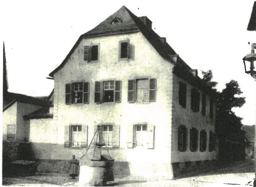
Ehemaliger Pfarriusbrunnen vor dem Haus Mühlfelder bis ca. 1910, Standort nicht mehr erkennbar, nur als Bild vorhanden
