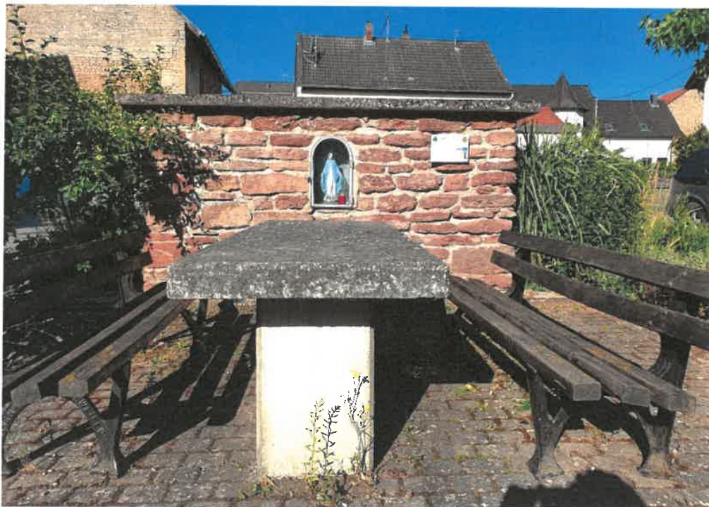
Sandsteinmauer, mit solchen Mauern aus rotem Sandstein wurden früher die Weinberge in Steillagen gestützt.
