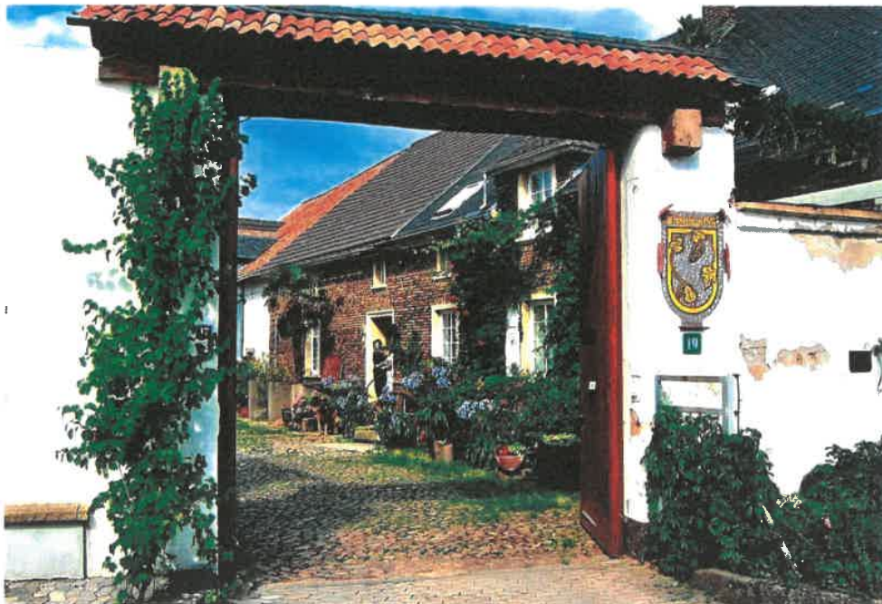
Mühle Brauch (Schmittmühle)
